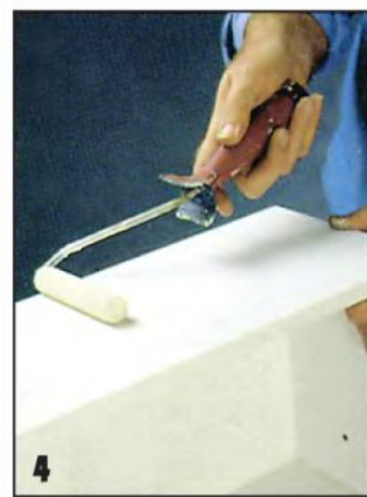
4 Дав шпатлёвке высохнуть, отремонтированные места обрабатывают шлифовальной шкуркой и, удалив пыль, грунтуют все поверхности разбавленной белой краской. Краска для окончательной отделки может быть любого цвета.
