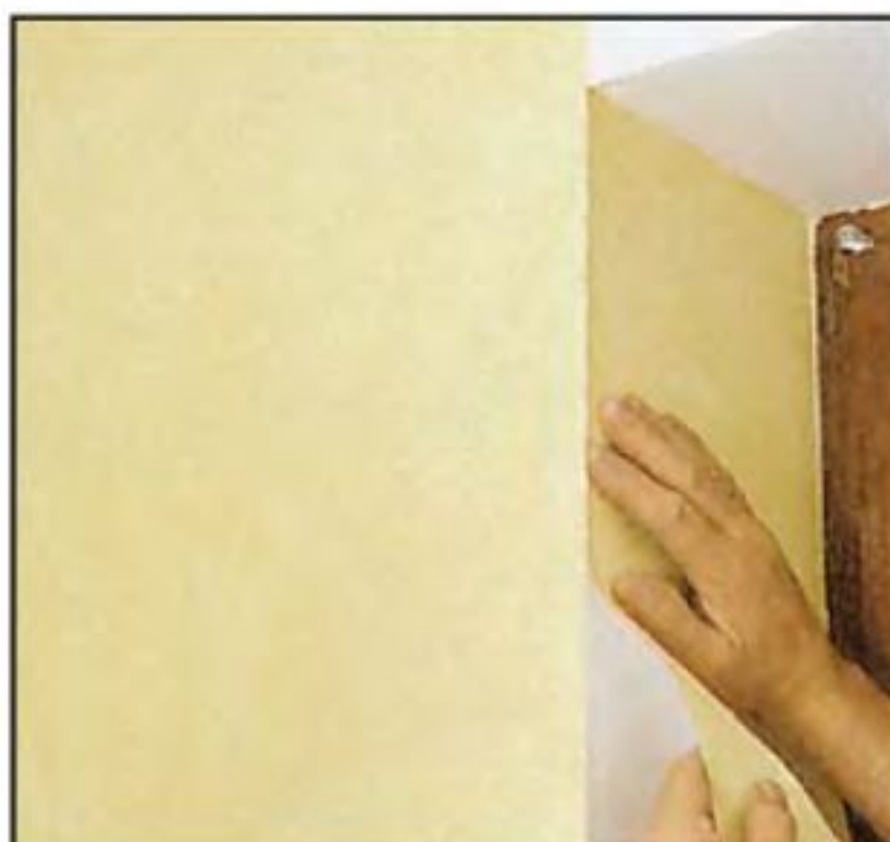
Обои из нетканого материала соединяют встык и на наружных углах. Загибать обои за угол из-за их жёсткости не рекомендуется.
