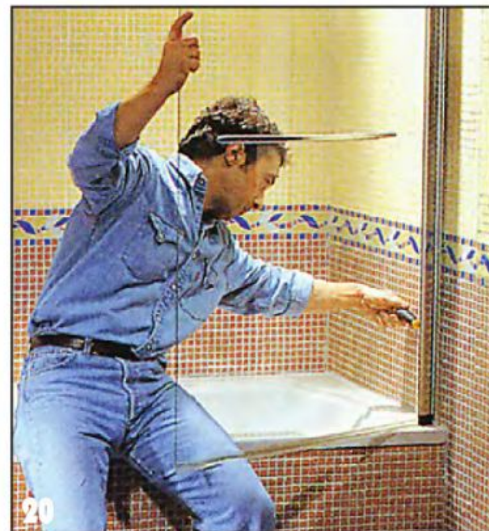
20 Стеклянную складную шторку с ручкой навешивают на установленный перед этим профиль. Следует соблюдать осторожность, такое стекло — хоть и закалённое, но довольно хрупкое. Нижний край шторки должен быть параллелен краю ванны.
