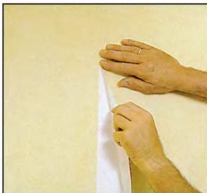
Обои под «растушёвывание» соединяют друг с другом встык. При приклеивании структурированных обоев из нетканого материала случайные следы клея на них крайне нежелательны.
