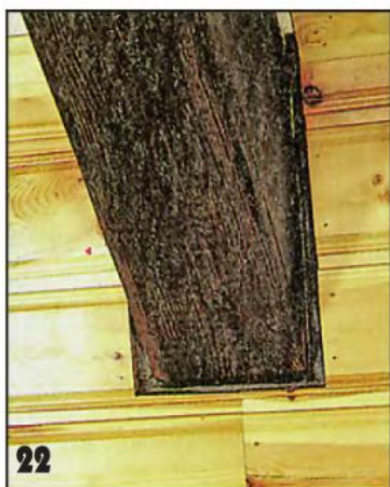
22 Так выглядит обшивка в зоне ригеля.
