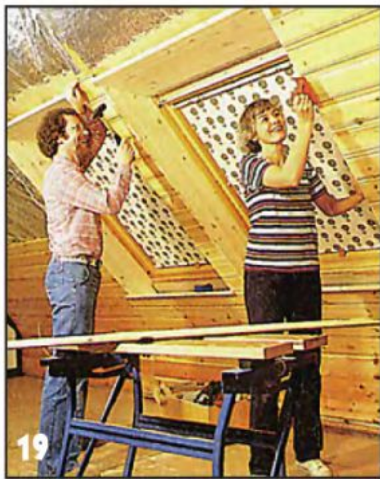
19 Острые рёбра торцевых кромок досок обшивки у оконных проёмов аккуратно скругляют шлифовальной шкуркой.
