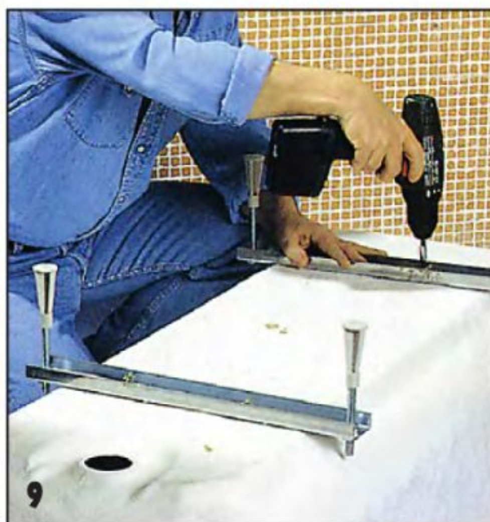
Акриловая ванна оснащена регулирующимися ножками. Под ней проходят два параллельных металлических профиля, к которым и прикреплены эти ножки.
