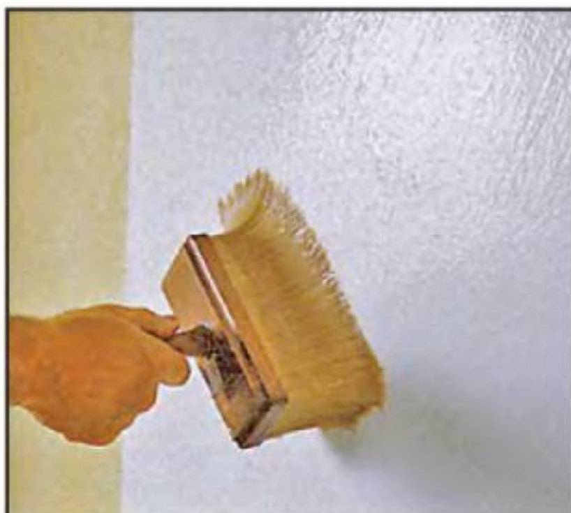
При оклейке стен обоями из нетканого материала клей наносят не на тыльную сторону обоев, а на стены.
