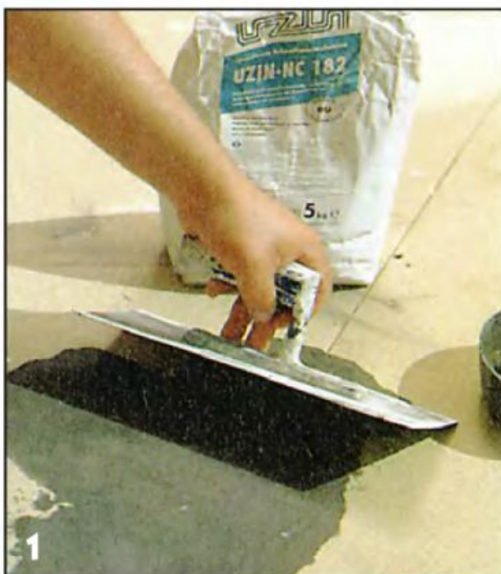
1 Швы между плитками (ДСП) основания пола шпатлюют, аккуратно разравнивая шпатлёвку в зоне стыков.
