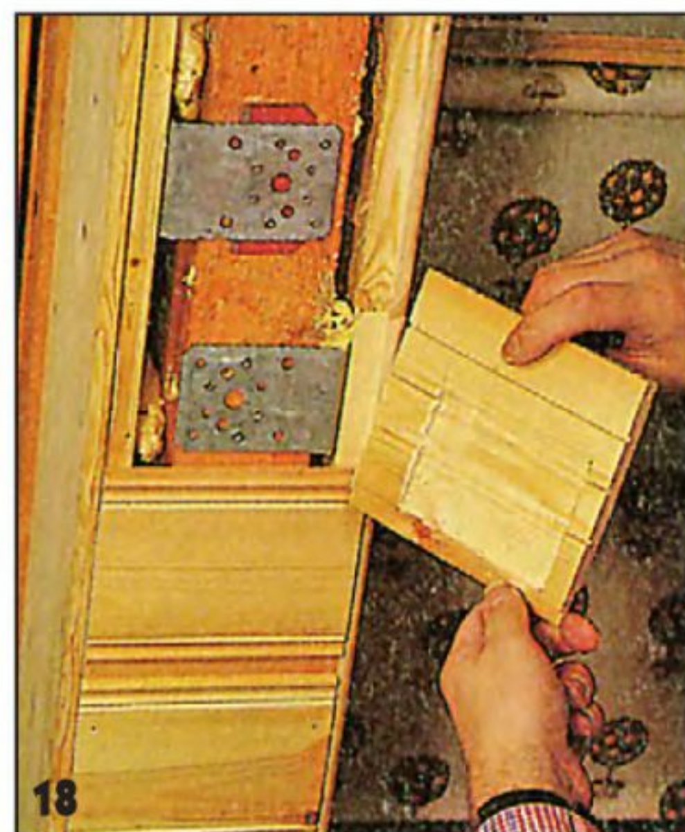
18 Одну за другой подгоняют дощечки обшивки между оконными проёмами.
