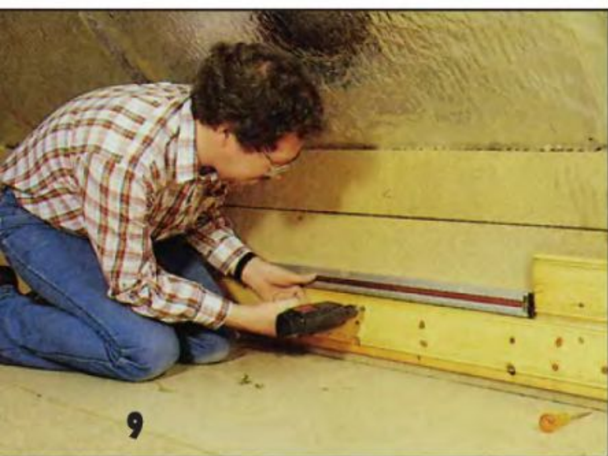
Убедившись, что первая доска выставлена правильно, крепят её окончательно к ДСП декоративными гвоздями или шурупами.
