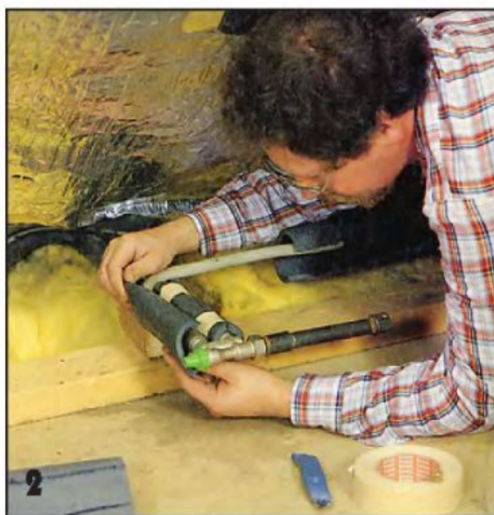
2 За возводимой вертикальной стенкой прокладывают антенные кабели и трубы отопления, утеплив предварительно свесы крыши минеральной ватой.
