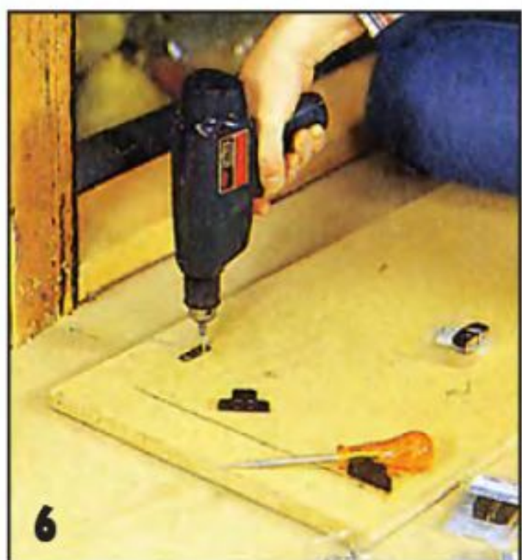
Привинченные магнитные защёлки надёжно удерживают ревизионный люк из ДСП, обшитой вагонкой.
