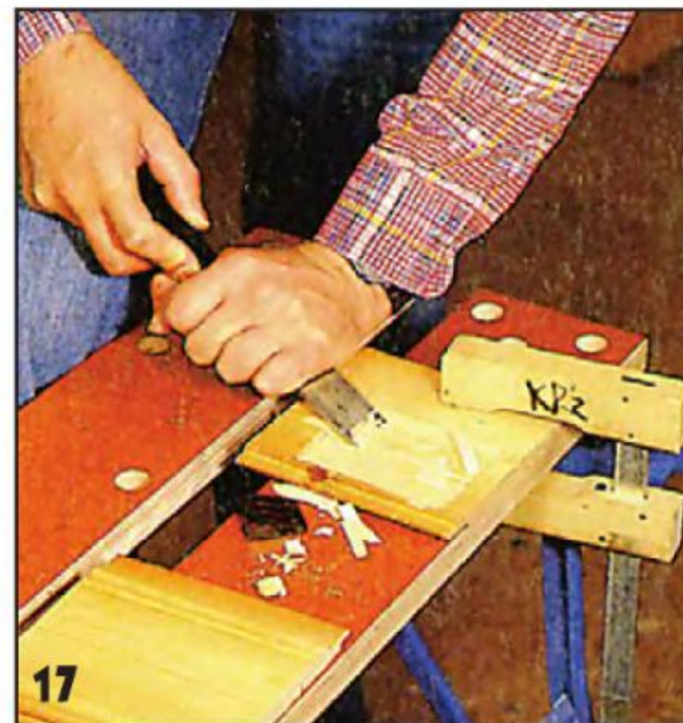
17 По краям дощечек выбирают углубления для уголков, на которых держится облицовка откосов оконных проёмов.
