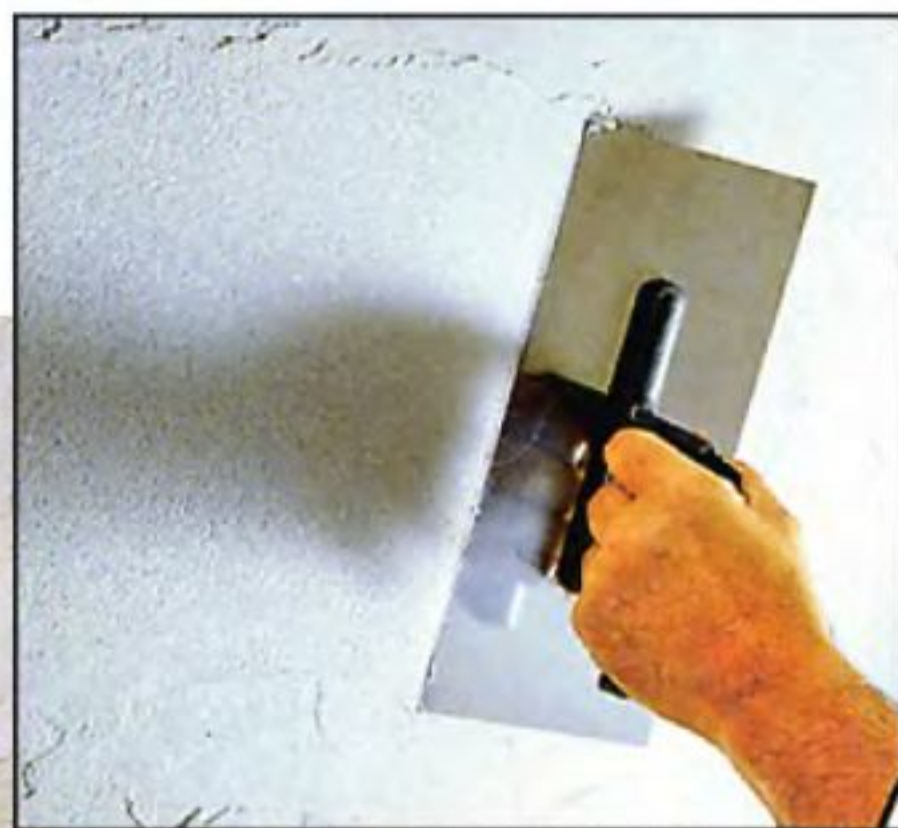
С помощью кельмы шпатлёвку наносят тонким слоем на стену и сразу же придают покрытию требуемую структуру.
