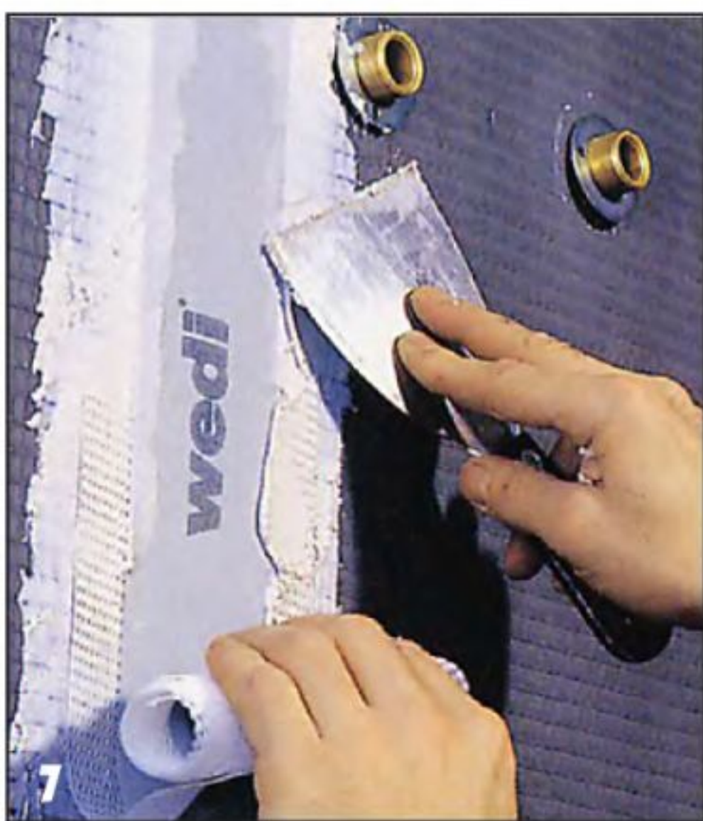
Стены обшивают полистироловыми плитами, заделывая раствором и усиливая стыки армирующей стекловолоконной сеткой.
