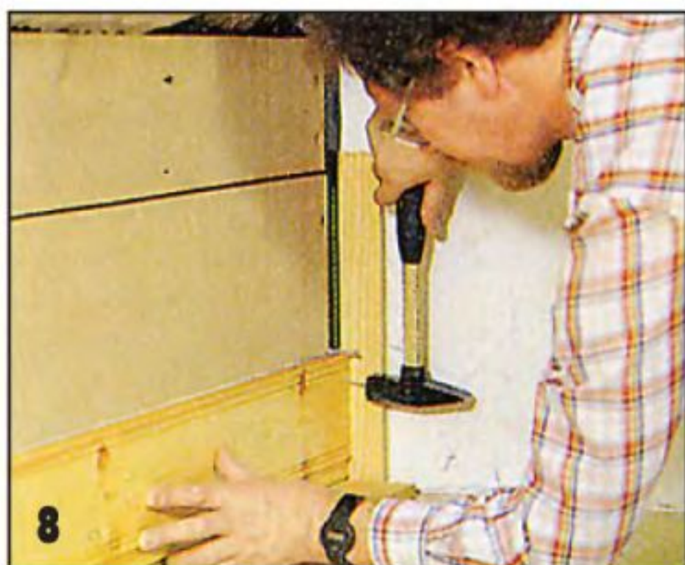
Первый ряд досок сначала крепят временно, чтобы точно выверить его.
