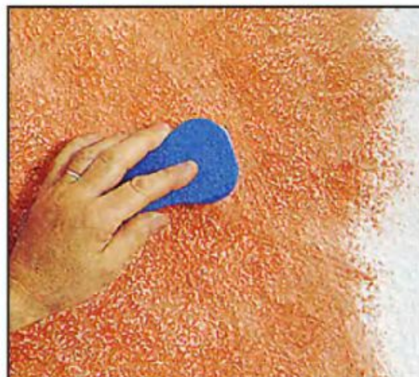
Попытка создать требуемый эффект на волокнистых обоях с грубой структурой окажется неудачной — будет только сильнее выделяться их структура.
