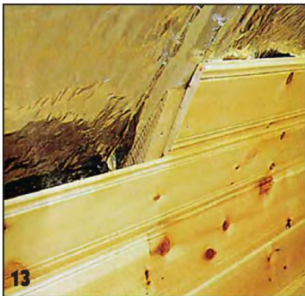
13 ...а формируют плавный слегка скруглённый переход, используя подкладки.
