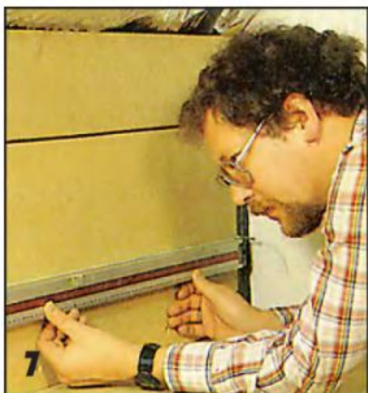
По уровню и шнуру тщательно размечают положение первого ряда шпунтованных досок.
