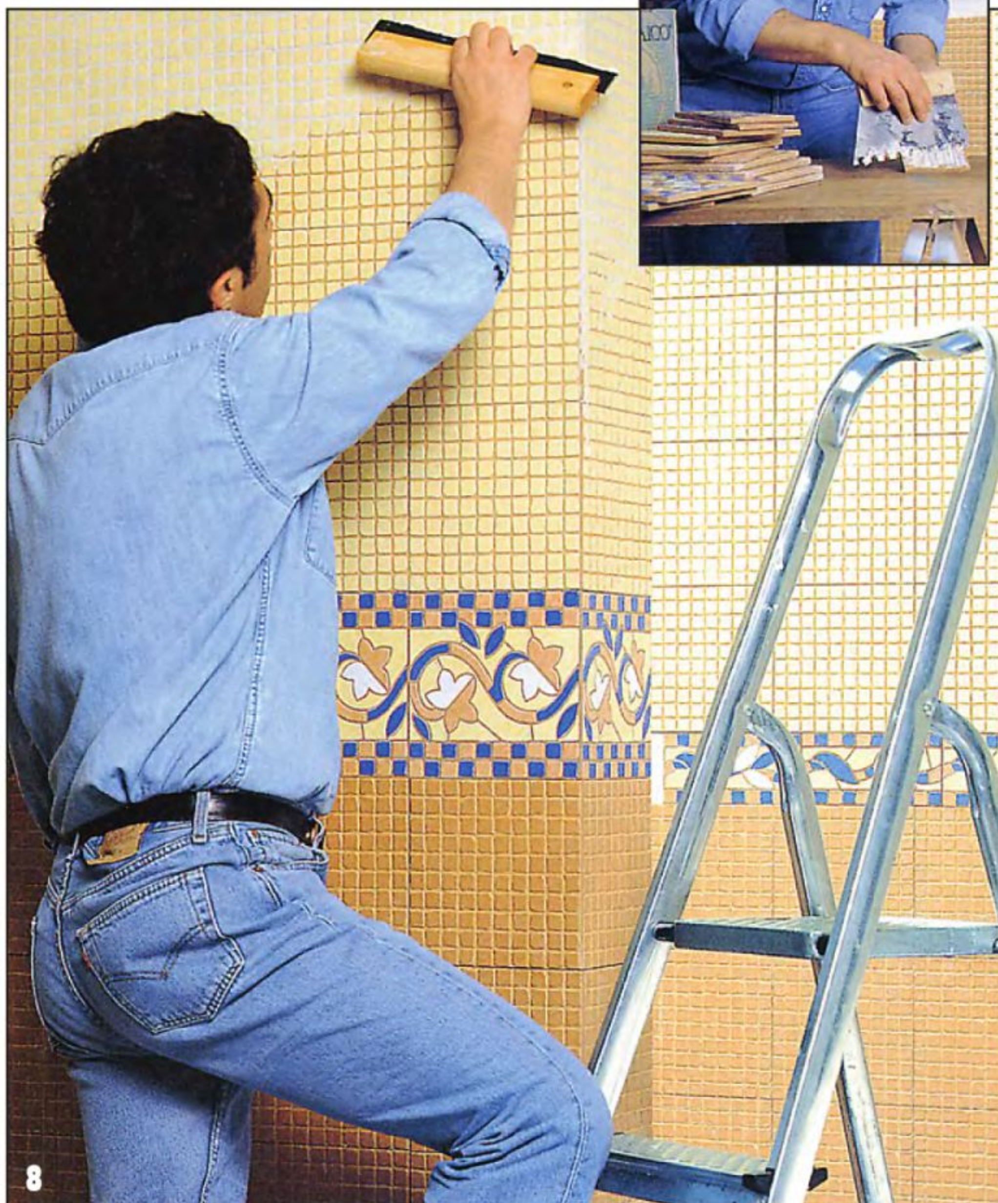
В данном случае для облицовки использовали квадратной формы маты из мозаичной керамической плитки.
