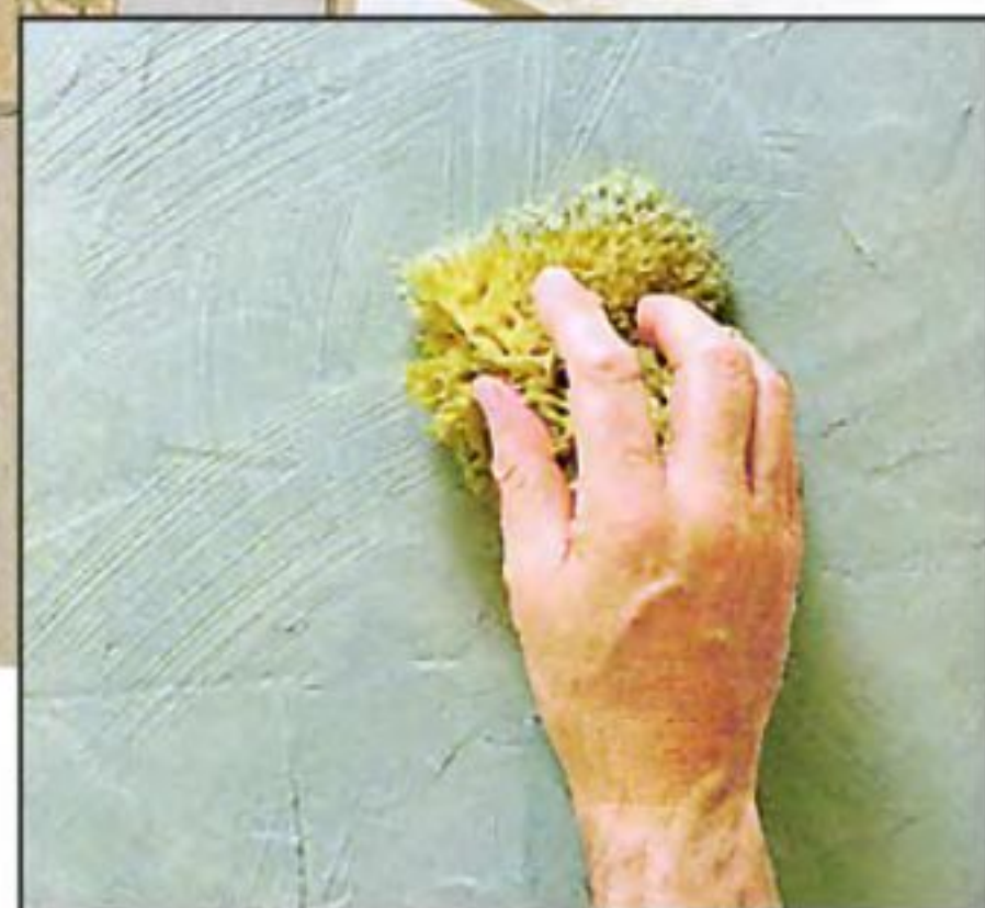
Нанесённую на стену восковую лазурь аккуратно растирают влажной губкой.
