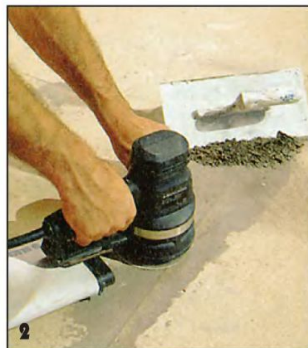
2 Дают шпатлёвке просохнуть (а сохнет она довольно быстро), зашпаклёванные места шлифуют.
