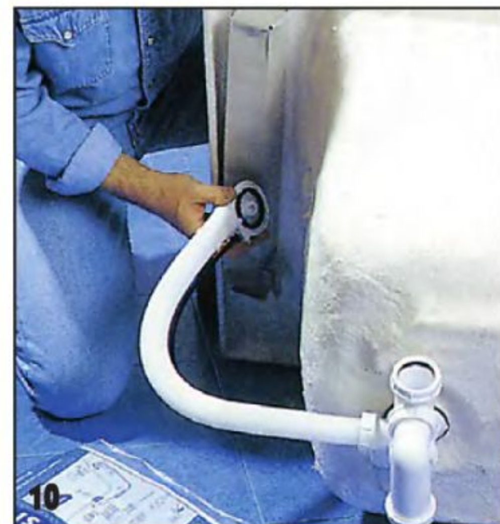
В комплект ванны входит и пластиковая сливная арматура с сифоном и подключённой к нему трубой перелива.
