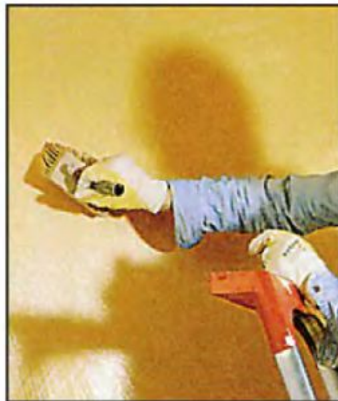
Сначала на всю стену наносят краску основного тона.
