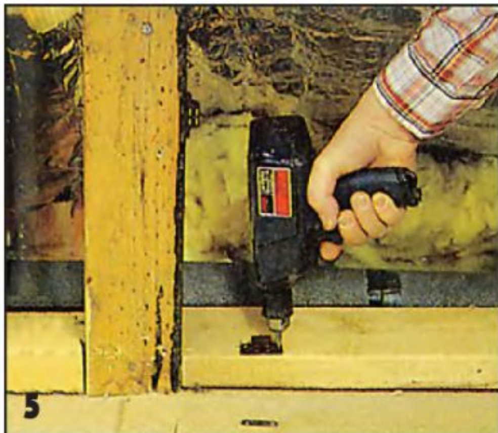
Чтобы обеспечить доступ к проводке и трубам, в вертикальной стенке предусматривают ревизионный люк.
