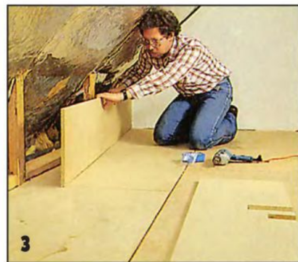
3 После выверки по уровню и шнуру элементов каркаса раскраивают и подгоняют подложку из ДСП.
