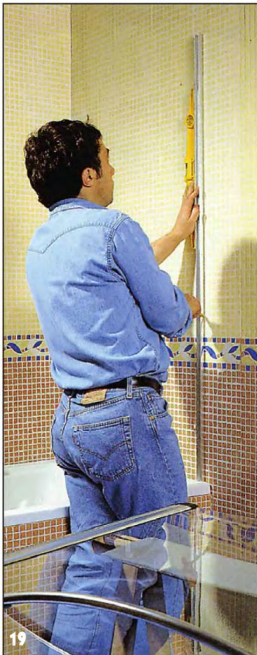
19 Напротив края ванны на стене монтируют профиль для подвешивания стеклянной шторки. Силиконовый герметик наносят на тыльную кромку профиля перед окончательным креплением к стене.
