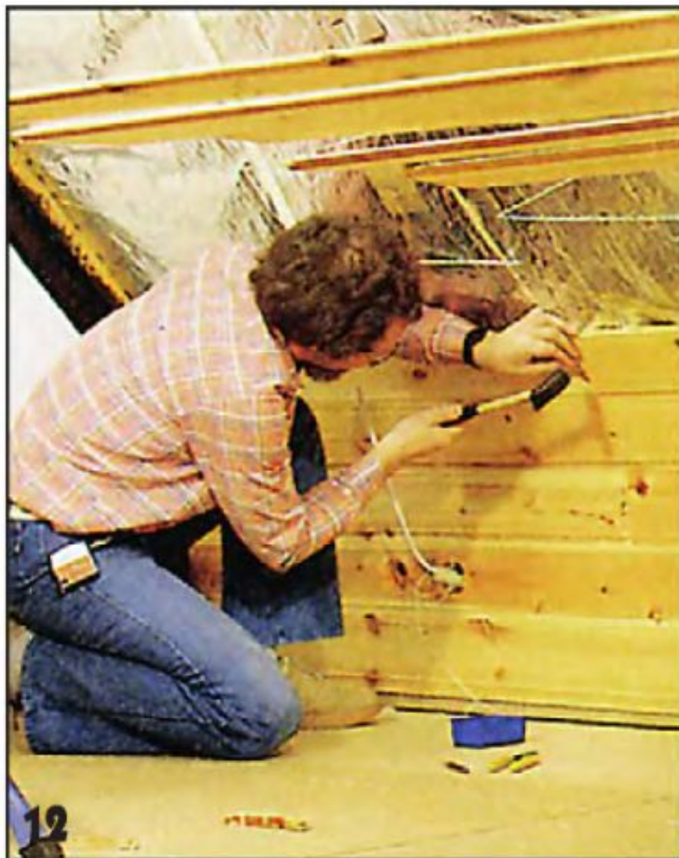
12 В зоне перехода от вертикальных стенок к наклонным доски обшивки укладывают на смежных поверхностях не под углом друг к другу,...
