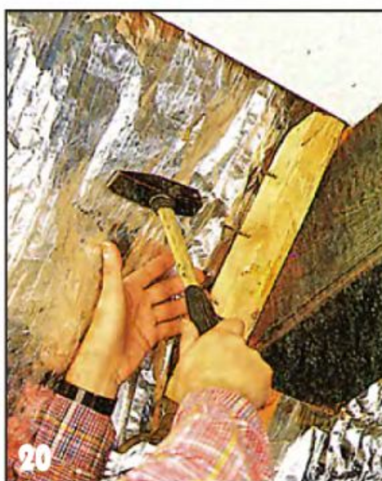
20 Для крепления верхних досок обшивки к ригелям прибивают несущие бруски.
