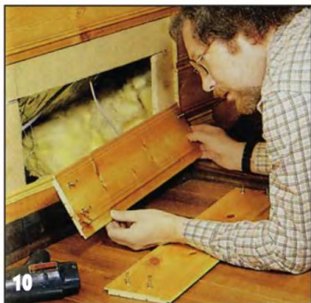
Для ревизионного люка шпунтованную доску раскраивают по его размерам.
