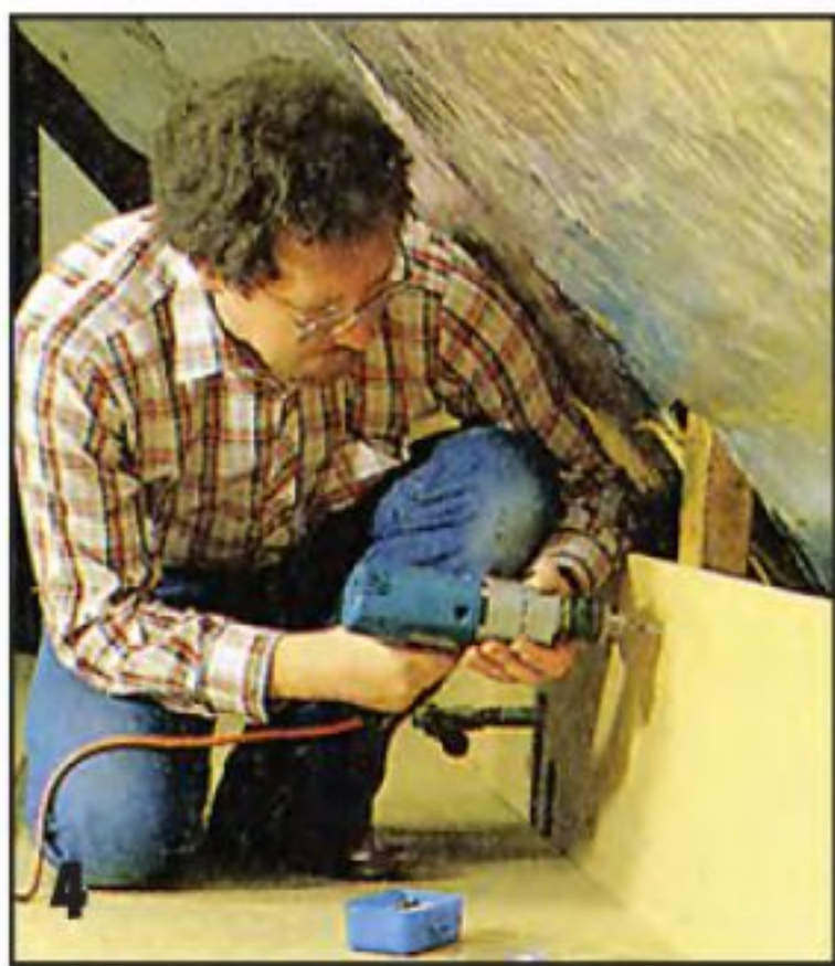
Электровинтовёрт облегчает крепление обшивки шурупами, ведь их нужно вкрутить не один десяток.
