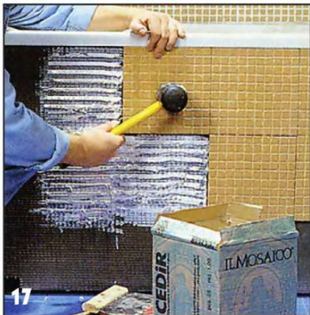
17 Маты мозаичной плитки приклеивают к основе без особых приготовлений. Ведут облицовку сверху вниз (от края ванны — к полу).
